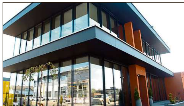
Auch beim Neubau hat Wolfgang Bliestle mit seinem Team die Planung selbst in die Hand genommen, so dass alle Gebäudekomplexe in der Marie-Curie-Straße wie aus einem Guss wirken.
