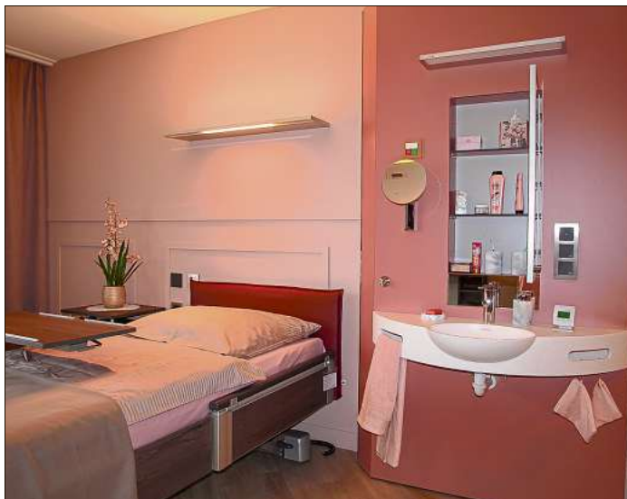
Für gehobene Ansprüche: Bei dieser Lösung lässt sich beispielsweise das Waschbecken durch eine Drehwand flexibel im Wohn- oder im Badezimmer nutzen.
